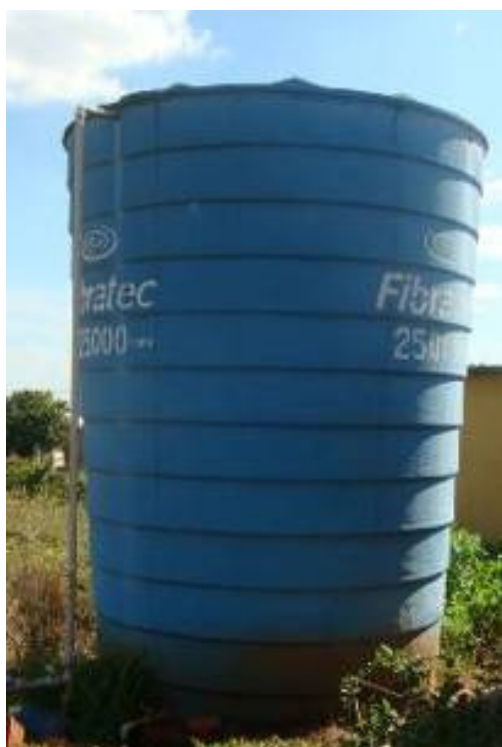
FIGURA 07: CAIXA DE ARMAZENAMENTO DE ÁGUA PÓS O PROCESSO DE DESTILAÇÃO
