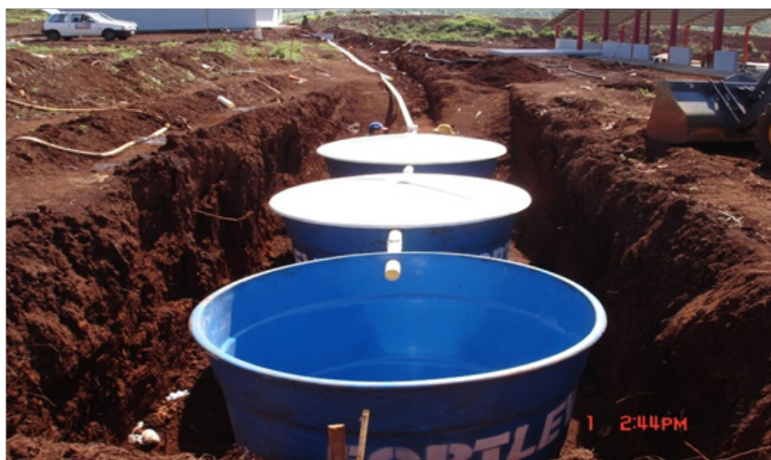
FIGURA 2- FOTO DA FOSSA BIODIGESTORA NO CTC - CENTRO DE TRIAGEM E COMPOSTAGEM, SITUADO NA CIDADE DE MARIALVA/ PR.
