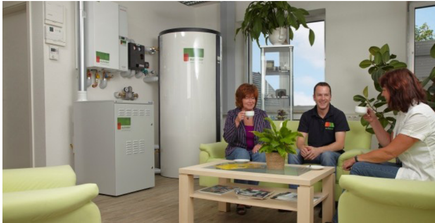
FIGURA 12 - CASA EQUIPADA COM CÉLULA A COMBUSTÍVEL E RESERVATÓRIO TÉRMICO (ÁGUA QUENTE)
