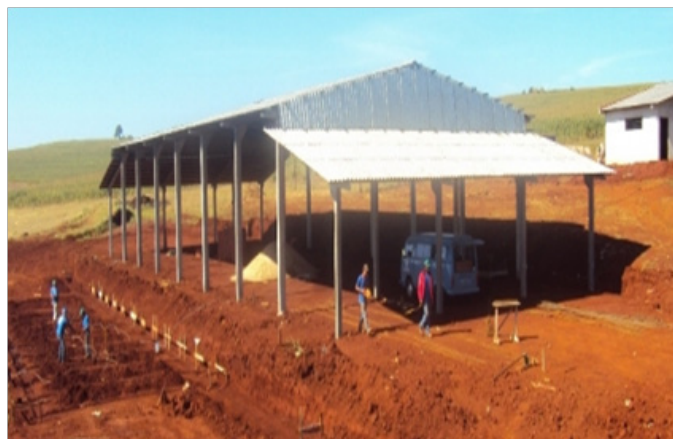
FIGURA 1- FOTO DO INÍCIO DA CONSTRUÇÃO DO SETOR DE SANEAMENTO E DE TRATAMENTO DE ESGOTOS, NO MUNICÍPIO DE MARIALVA/PR.
