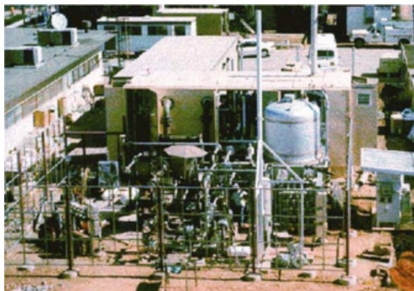
FIGURA 7 - PLANTA DE GERAÇÃO DE ENERGIA ELÉTRICA BASEADA NA TECNOLOGIA DE CARBONATO FUNDIDO (MCFC) - SAN DIEGO, CALIFÓRNIA 1997 - CORTESIA DO NATIONAL ENERGY TECHNOLOGY LABORATORY
