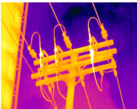
Figura 1: Imagem termográfica da inspeção de redes.
