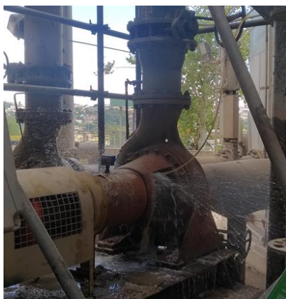
Figura 2 – Bomba centrífuga danificada
