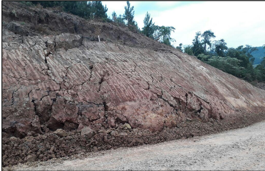
Figura 13– Segmento em que houve o rompimento Trecho 06.
