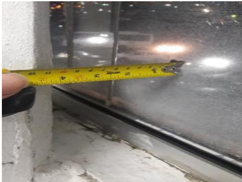
Figura 9 – Abertura entre as salas de bloco de concreto
