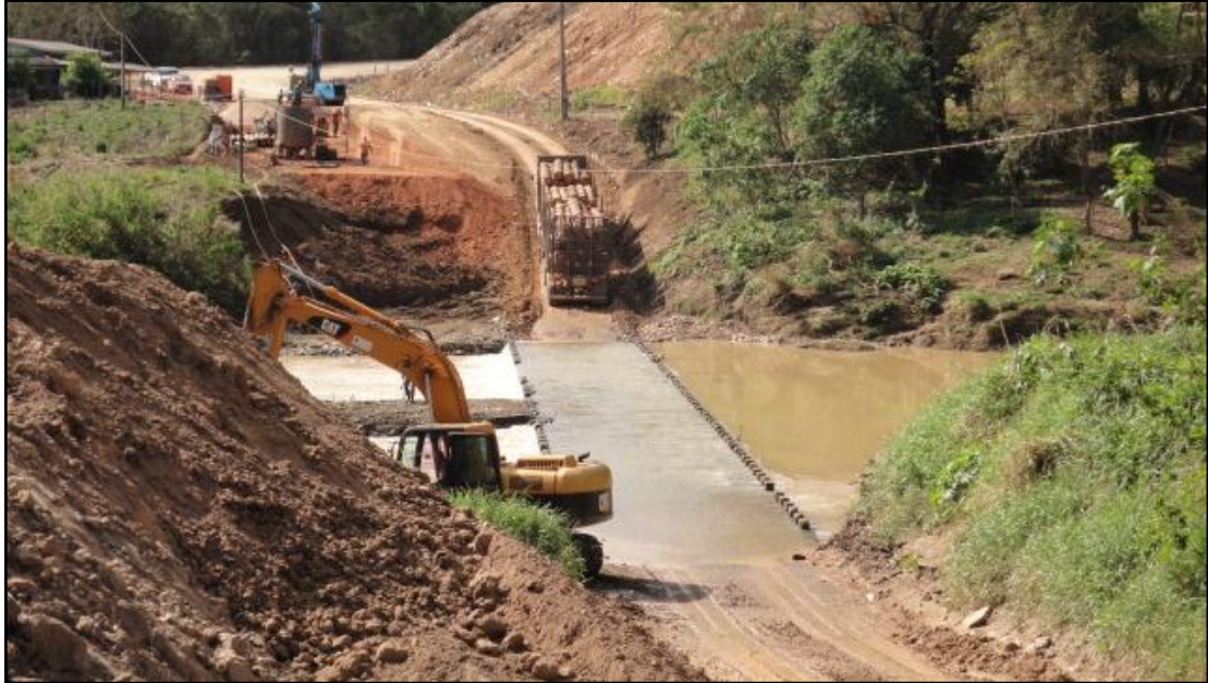
Figura 6 - Ponte da União – Parcialmente alagada 22/08/2017
