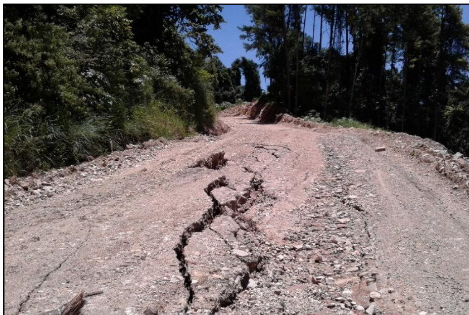
Figura 12 – Segmento em que houve o rompimento Trecho 05.
