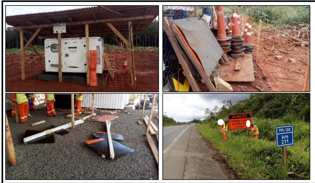
Figura 21 – Sinalização de segurança utilizado na obra
