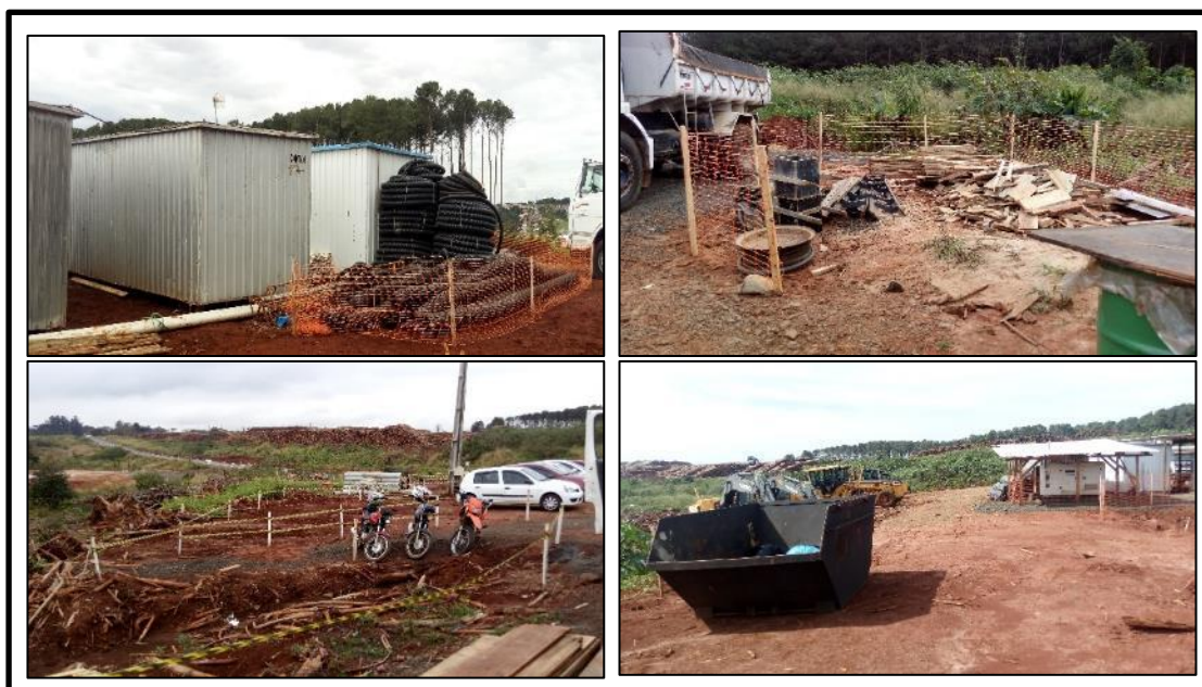
Figura 24 – Organização e limpeza do canteiro de obras
