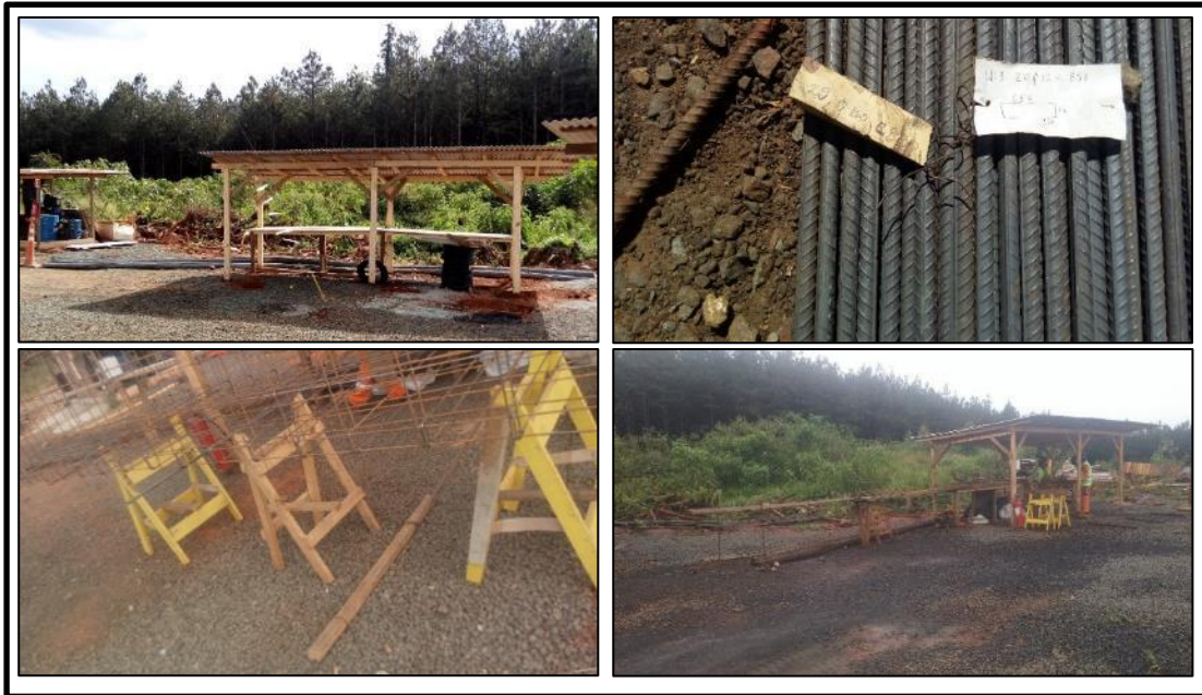
Figura 12 – Local da baia da armadura de aço
