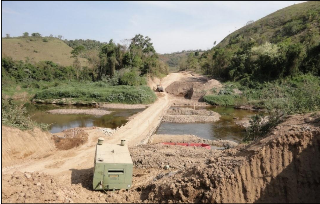
Figura 8 - Início da terraplanagem no local da ponte – 11/09/2017
