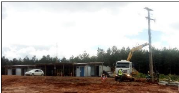
Figura 15 – Instalação elétrica do canteiro
