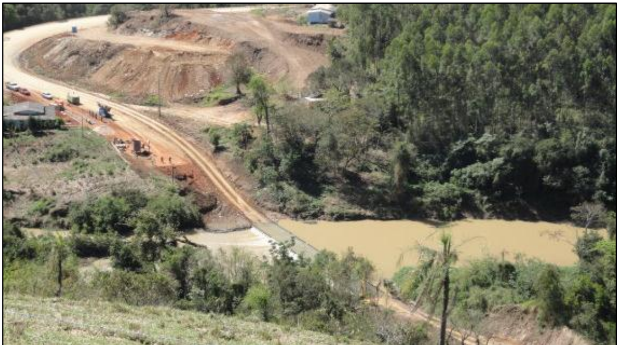
Figura 7 - Ponte da União – Parcialmente alagada 22/08/2017
