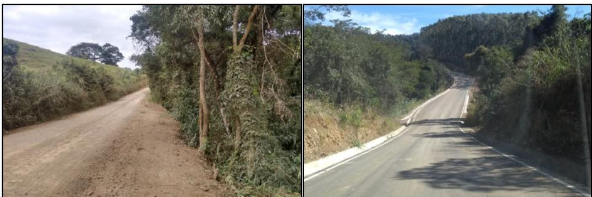
Figura 4 – Início trecho 03 – 13/04/2017 x Trecho 03 finalizado 21/05/2018
