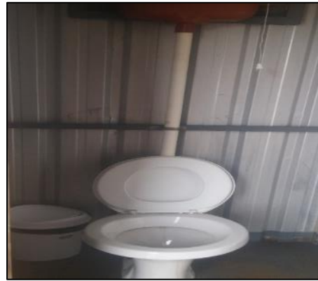
Figura 8: Instalações sanitárias (contêiner)
