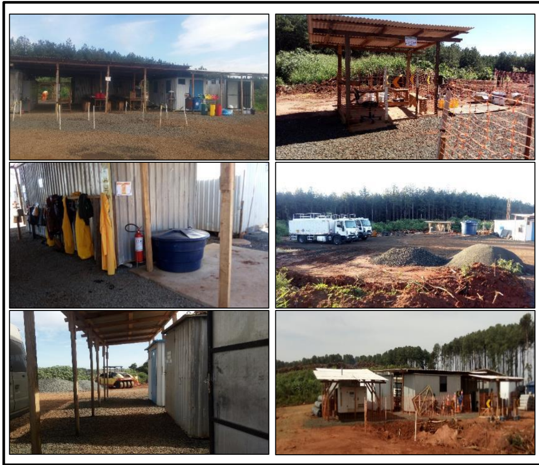
Figura 23 – Organização e limpeza do canteiro de obras
