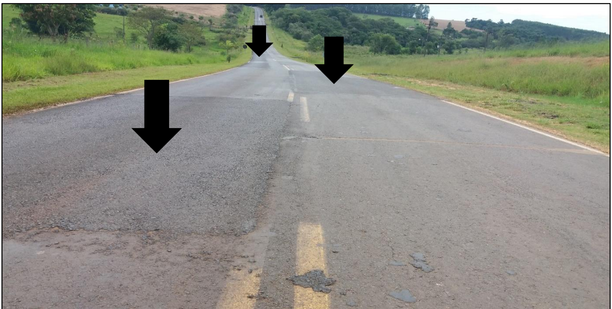
Figura 01: Pavimento restaurado com CBUQ
