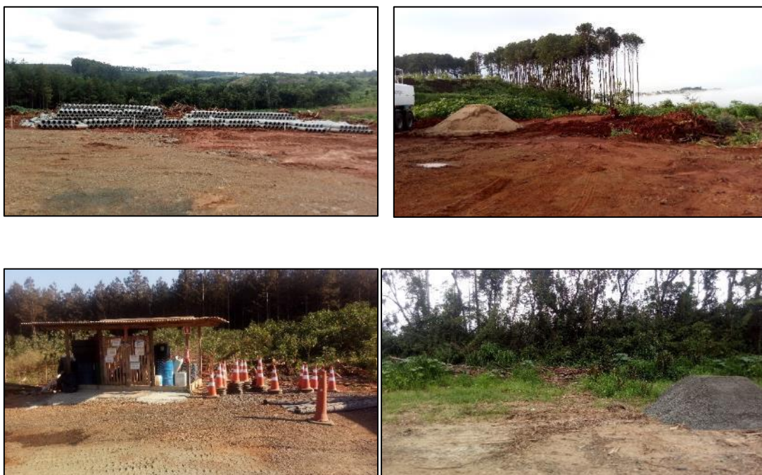
Figura 19 – Armazenagem e estocagem dos materiais no canteiro de obras
