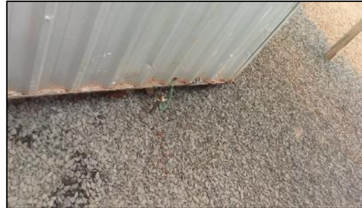
Figura 16 – Aterramento container
