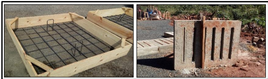
Figura 13 – Local da baia das formas e concretagem
