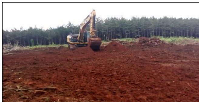
Figura 17 – Operação de máquina na obra
