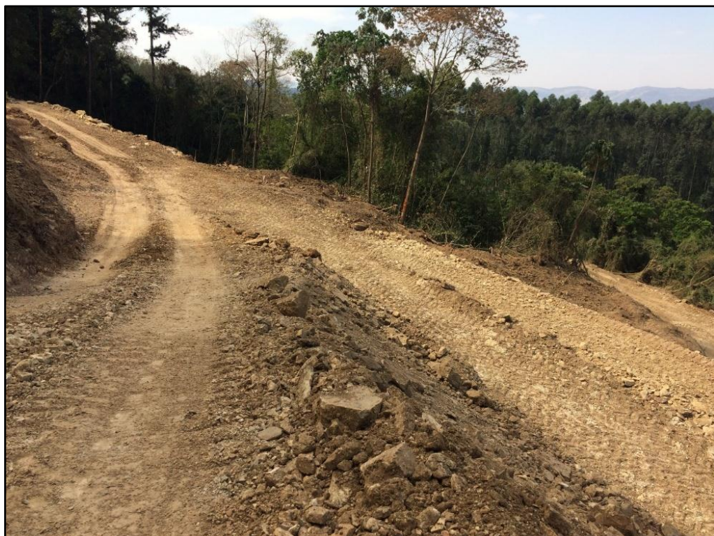
Figura 14 – Trecho 04 – local onde foi substituído material do subleito.
