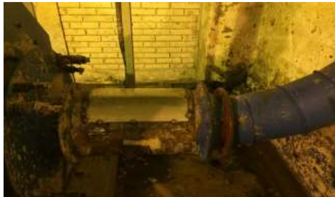
Figura 17: Tubulação com corrosão
