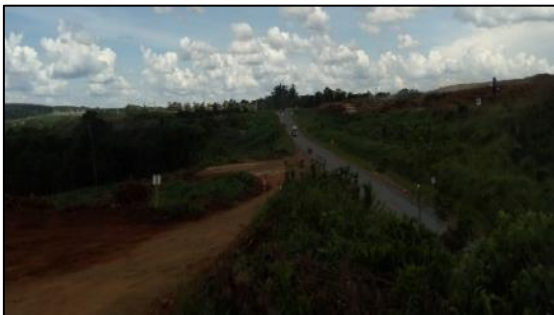
Figura 5 – Local do canteiro de obras
